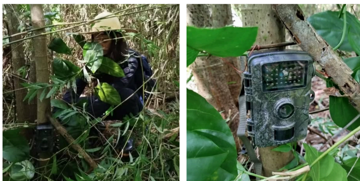
Figura 1: Instalação das câmeras de monitoramento no Córrego Sussuapara (Palmas-TO)
