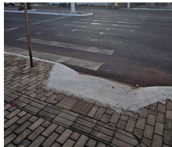
Figura 5: Alinhamento entre rampa e faixa
