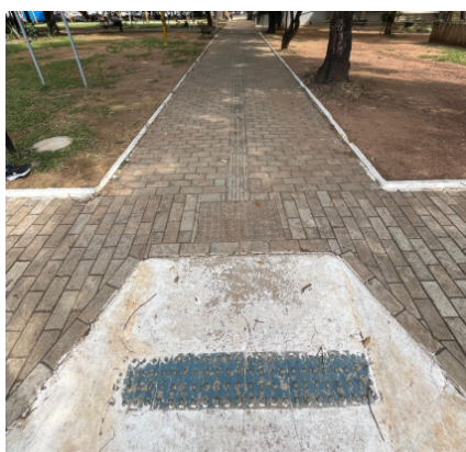
Figura 1: Rampa de acesso à praça.
