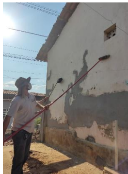
Figura 1- Limpeza da superfície
