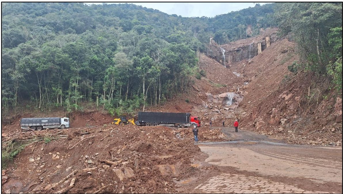
Figura 5: Mega escorregamento de massa em rodovia de acesso a Bento Gonçalves-RS. Fonte: DRM-RJ
