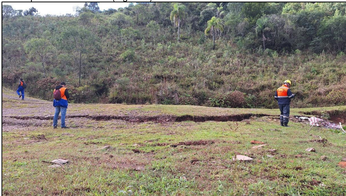
Figura 3: Equipes do DRM-RJ e Defesa Civil de Gramado-RS realizando vistorias para identificação de riscos geológicos remanescentes na zona rural do município.
