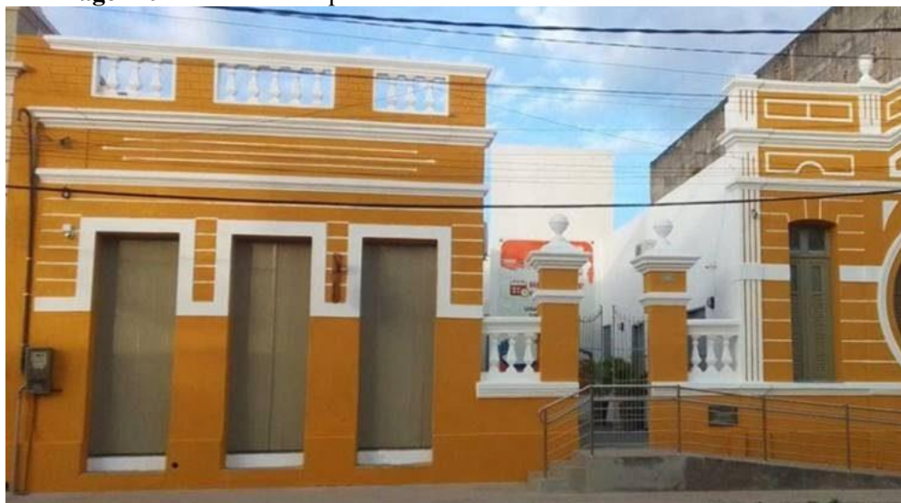
Imagem 01 – Fachada do prédio da Casa do Artesão do Seridó – CARTS
