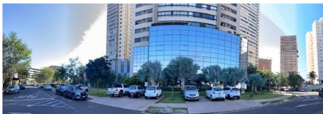
Figura 8: Foto de fachada interna na R. José Elias.
