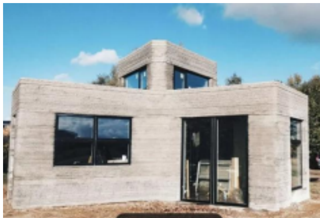
Figura 3. Maquete do modelo construtivo utilizando a impressão 3D de concreto.
