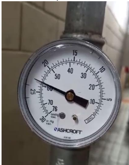
Imagem 3: manômetro pressão de vácuo da bomba
