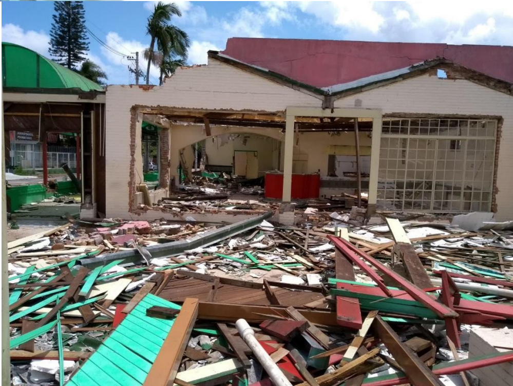
Imagem 3: Demolição do restaurante Bologna, 2017.
