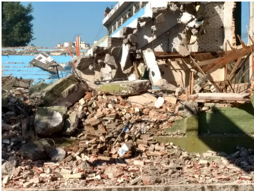
Imagem 4: Demolição do Ginásio da Brigada Militar, 2019.
