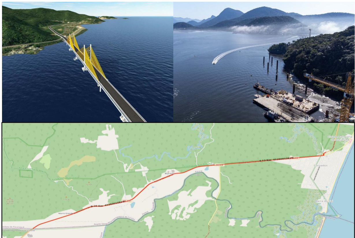
Figura 9- construção da ponte de Guaratuba e projeto de duplicação Guaratuba/Garuva
