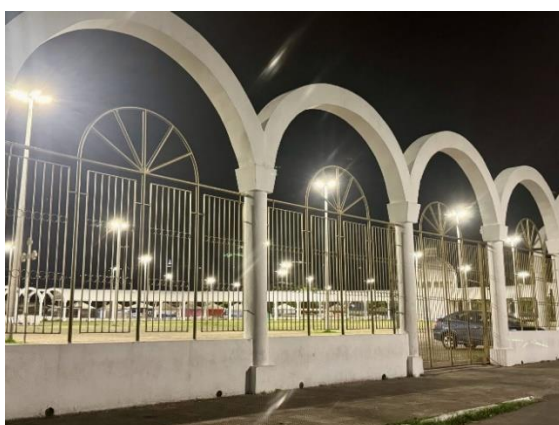
Figura 7: Praça da Matriz vista da Rua São Pedro.
