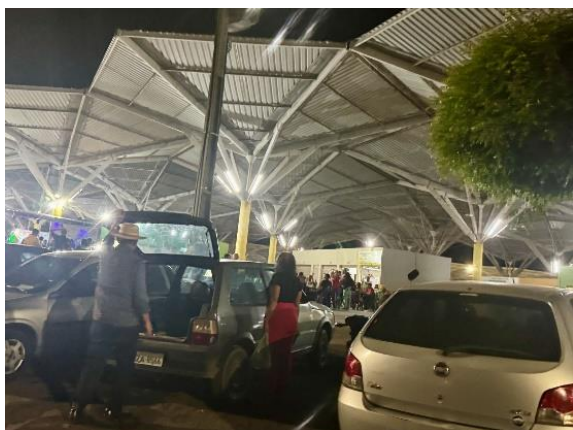
Figura 9: Centro de apoio ao romeiro vista da Rua São Pedro.
