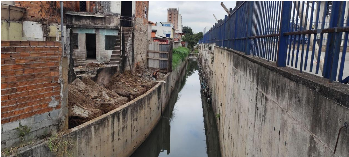
Figura 2: trecho da canaliza o do c rrego Pacie ncia, zona norte. (foto: Travassos, 2025)
