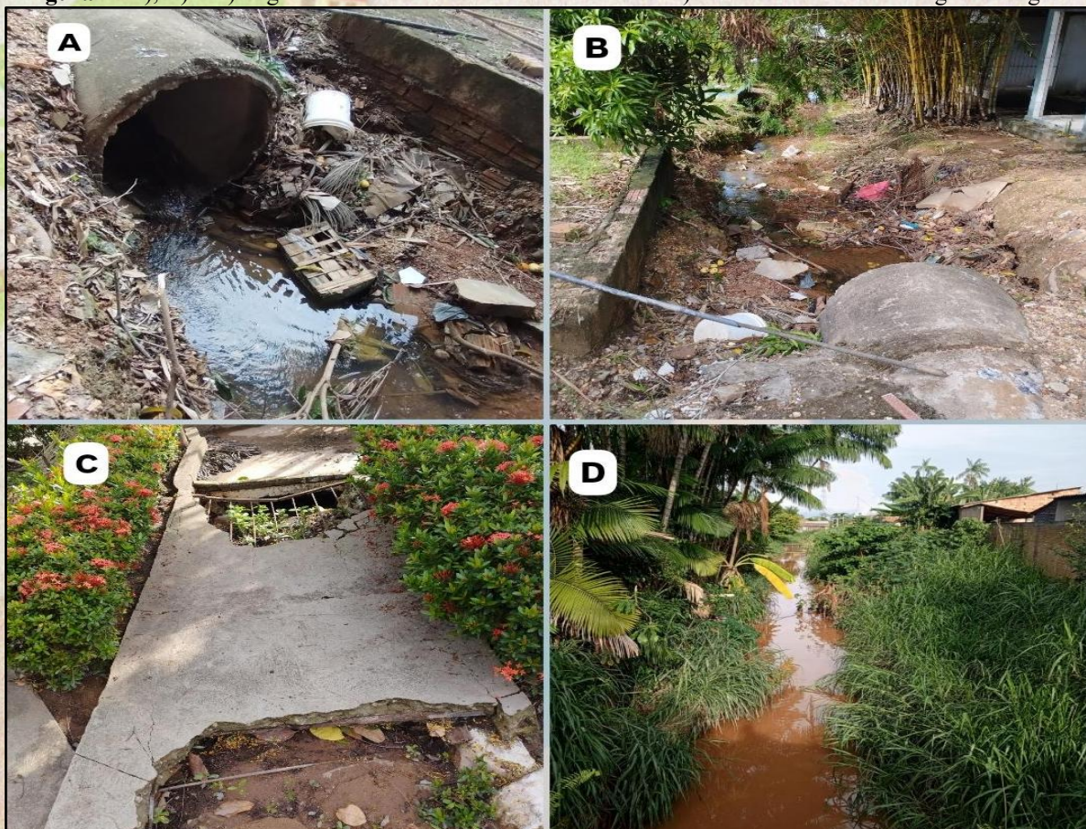
Figura 2- A), B) e C) Esgoto a céu aberto dentro do Cemitério e D) Grota criminosa onde esgoto deságua.
