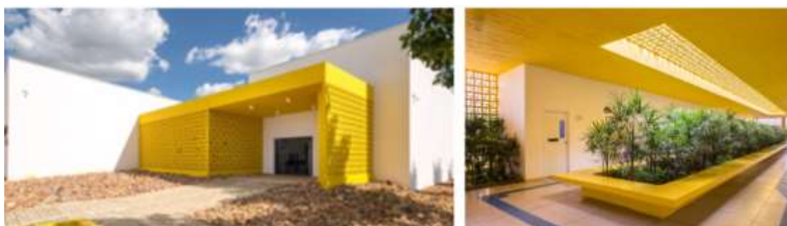
Figura 09: Núcleo de Prática Jurídica da Unileão- Fachada principal e circulação interna.
