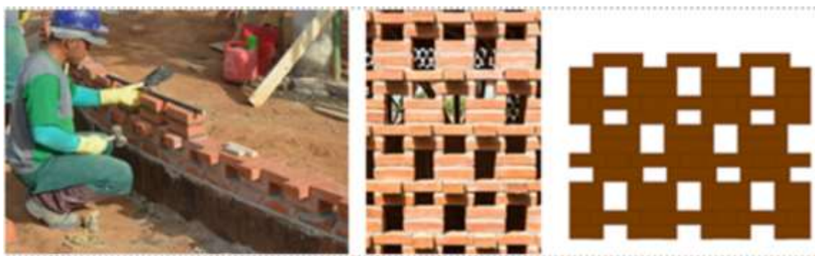
Figura 13: Processo de assentamento e detalhe do elemento vazado (foto e desenho esquemático) Fonte: Lins Arquitetos(2024)
