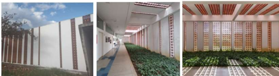
Figura 06: Vistas das faixas de cobogós das fachadas Fonte: Acervo da autora e Lins Arquitetos (2024)
