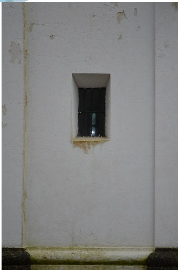
Projeto de MANOEL VIEIRA LEÃO (1727–1803) seteira (detalhe) localizada na torre, Catedral de São Pedro, 1755 Rio Grande, RS Fotografia da autora, 2022
