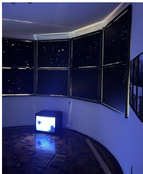
Imagem 6. Sala expositiva na Fundação Ecarta, na qual evidencia-se o mau acabamento do adesivo que deveria bloquear totalmente a luz externa.
