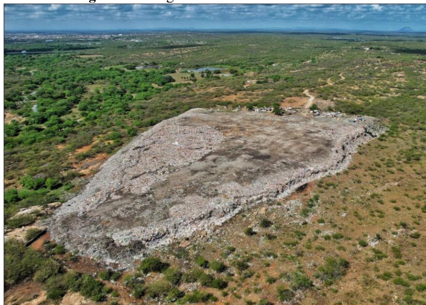
Figura 4 – Imagem aérea do lixão de Caicó/RN
