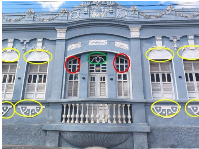
Figura 1 – Fotografia da fachada principal do Sobrado dos Delgado localizado na cidade de Esperança – PB.
