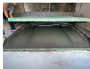
Figura 2 – Caixa separadora com acúmulo excessivo de água.
