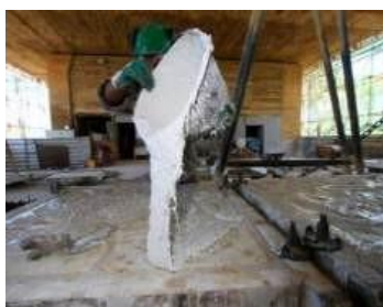
Figura 6 – Processo de fabricação do Cobogó Cais do Sertão na própria obra
