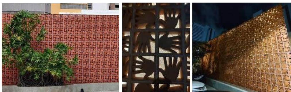
Figura 4 – Galeria Multiarte: visão diurna e noturna. Detalhe do cobogó
