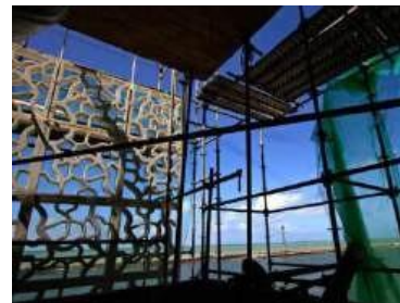
Figura 6 – Processo de fabricação do Cobogó Cais do Sertão na própria obra
