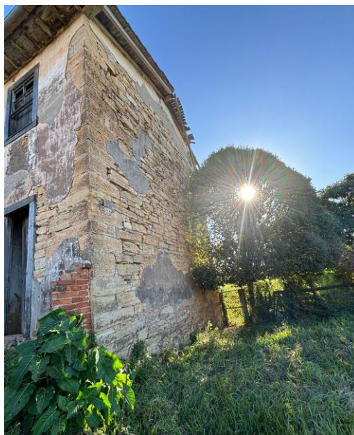
Figuras 6 a 9: Fachadas que apresentam o estado avançado de degradação, com descolamento pictórico, partes faltantes e grandes manchas de infiltração.
