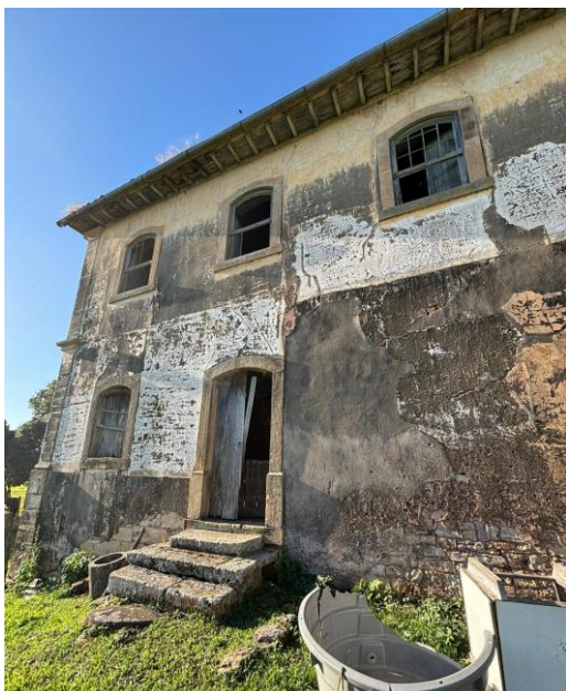
Figuras 6 a 9: Fachadas que apresentam o estado avançado de degradação, com descolamento pictórico, partes faltantes e grandes manchas de infiltração.
