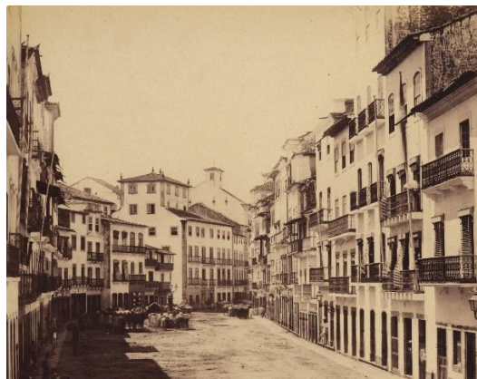
Figura 4 – Sobrados coloniais da antiga Rua dos Judeus, no Recife. Fonte: Wikipédia: domínio público.
