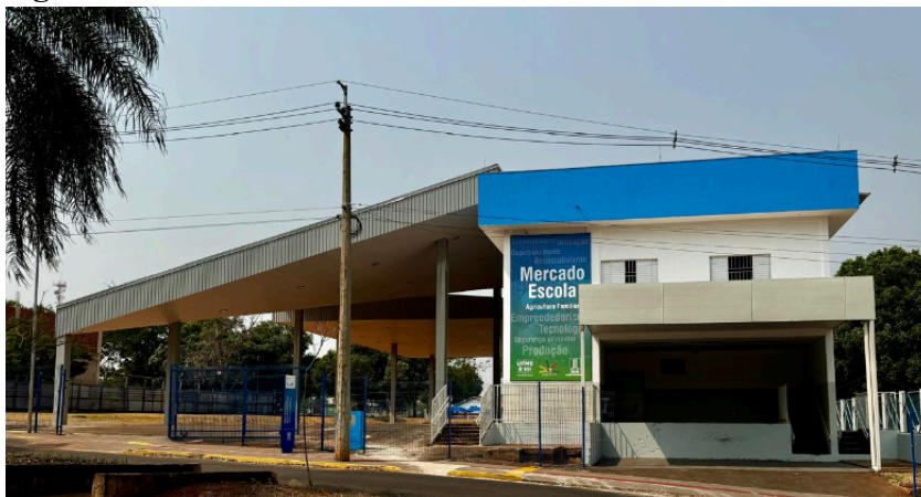
Figura 2 - Obras do Mercado Escola - UFMS
