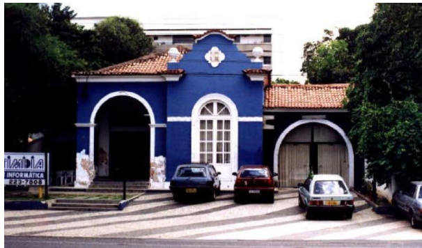
Figura 166: Residência Genival Castelo Branco de Carvalho, já demolida. Fonte: FMC (1998).
