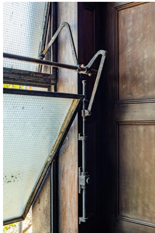
Figura 11 – Pormenores: estanteria Stahlunion e caixilharia Crittal. Fonte: Nelson Kon/Instituto Pedra (2023).
