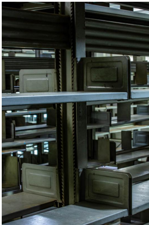
Figura 11 – Pormenores: estanteria Stahlunion e caixilharia Crittal. Fonte: Nelson Kon/Instituto Pedra (2023).
