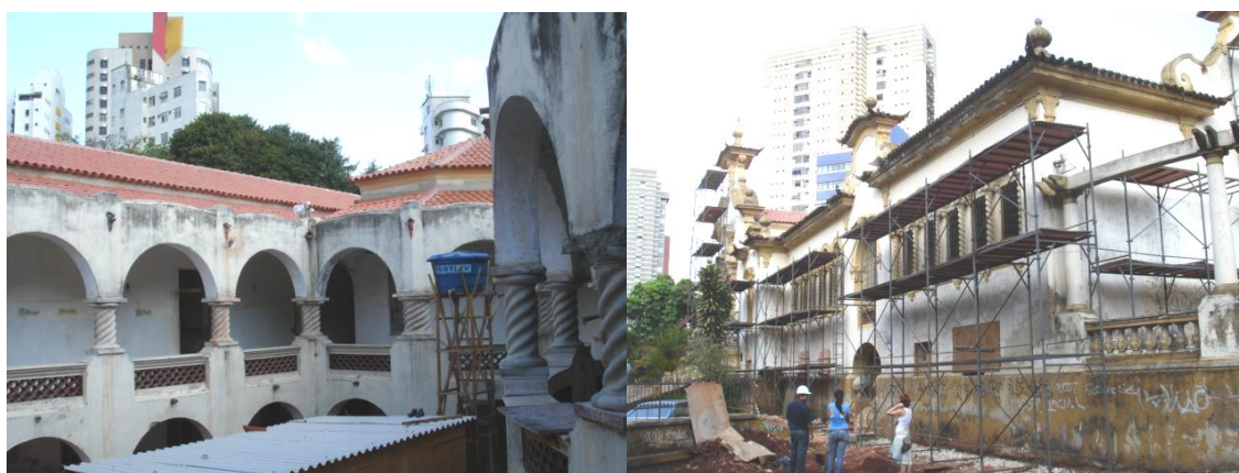
IMAGEM 03 e 04: Obras de restauração (Arquivos IEPHA/MG)
