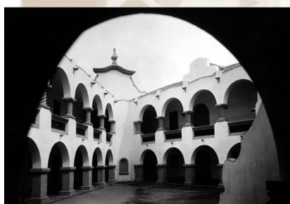
Vista parcial do pátio interno do Grupo Escolar Pedro II em Belo Horizonte/MG - Entre 1920 e 1930 - Fotógrafo: Igino Bonfili - Acervo: Arquivo Público Mineiro
