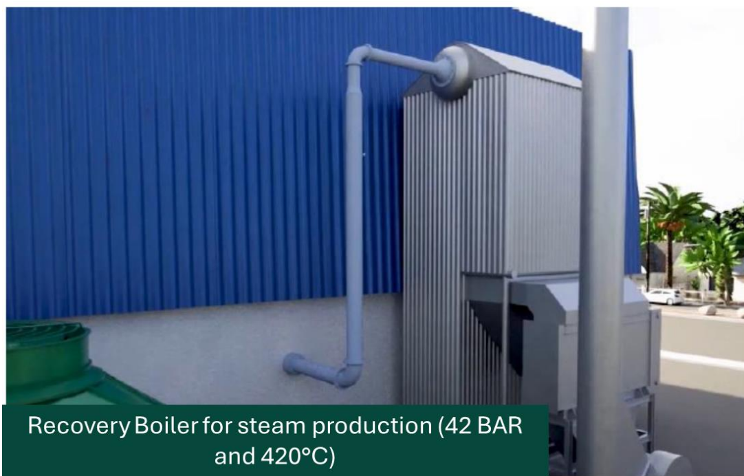
Figura 9- Caldeira de recuperação para produção de vapor
