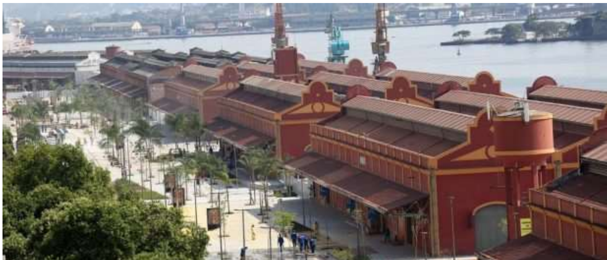
Figura 1- Vista do projeto do Porto Maravilha executado.
