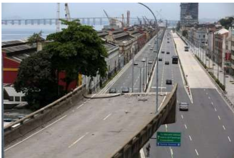
Figura 2- Resquícios da Perimetral em processo de demolição.
