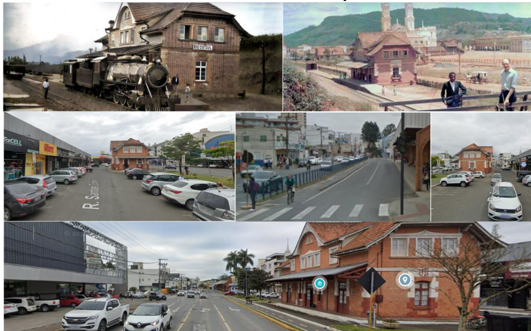
Figura 01: Estação Ferroviária Central de Rio do Sul antigamente e atualmente com a priorização do automóvel no entorno da Estação
