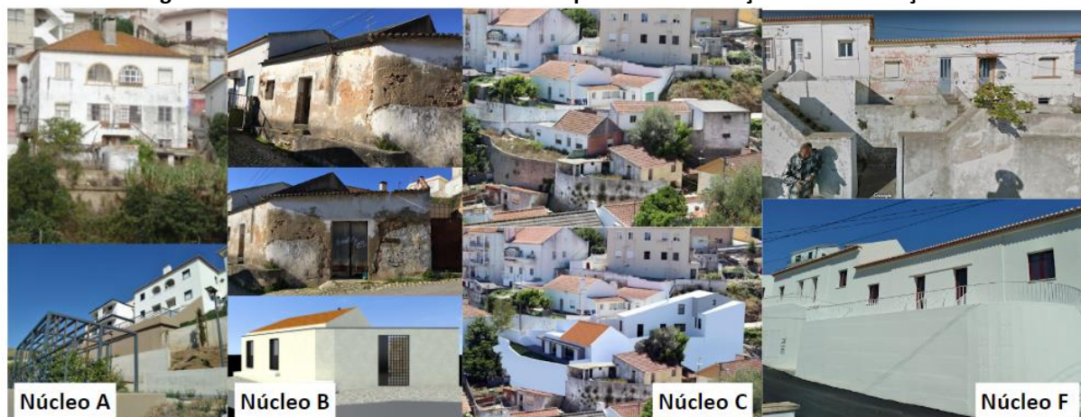
Figura 01: Núcleos habitacionais antes e depois das intervenções de reabilitação.
